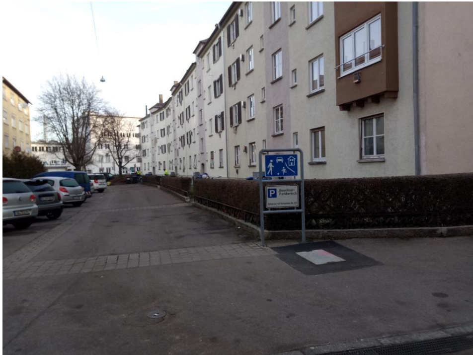
Bild 1: Bauareal am 27.01.22: Uhlandstraße Richtung Norden
