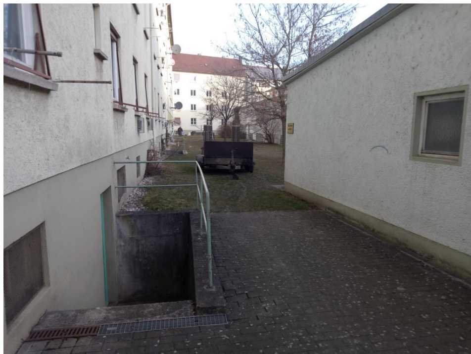
Bild 2: Bauareal am 27.01.22: Innenhof Gneisenaustraße (Richtung Norden)
